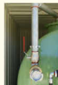
043.496.13 Remplissage déporté en façade
